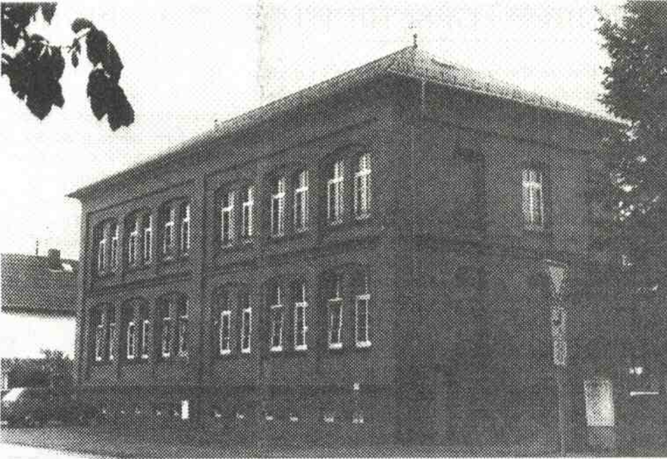
Das 100 Jahre alte Schulhaus in Ettingshausen im Herbst 1995.
