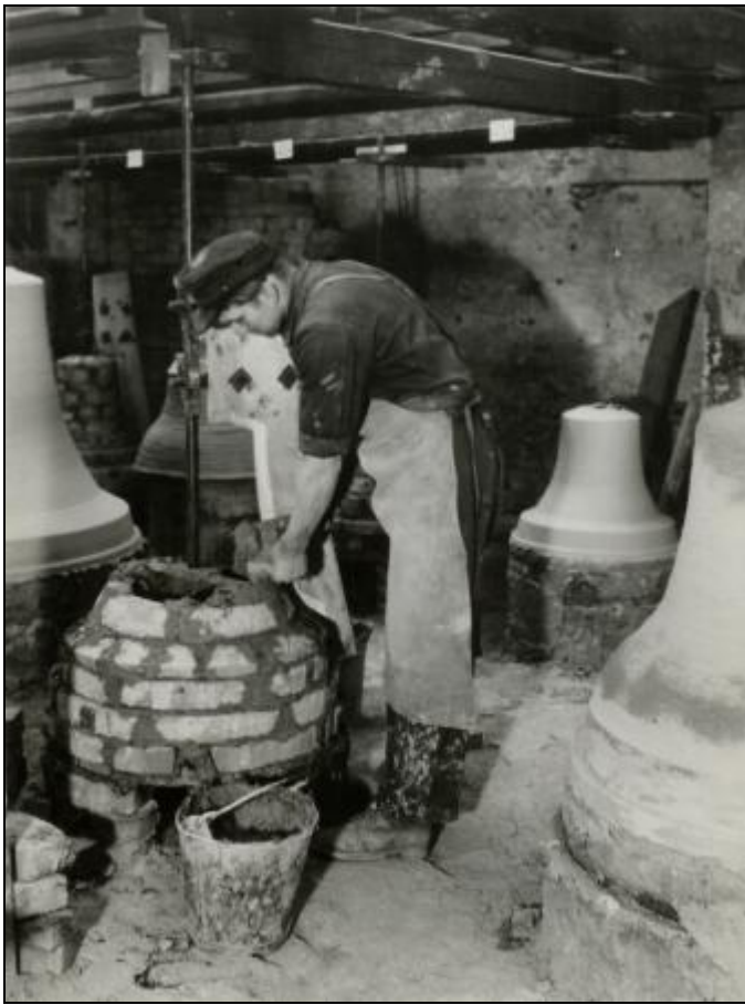
Die Arbeiten beginnen mit dem Aufmauern der Kernformen aus Lehmsteinen auf einem Formstand
